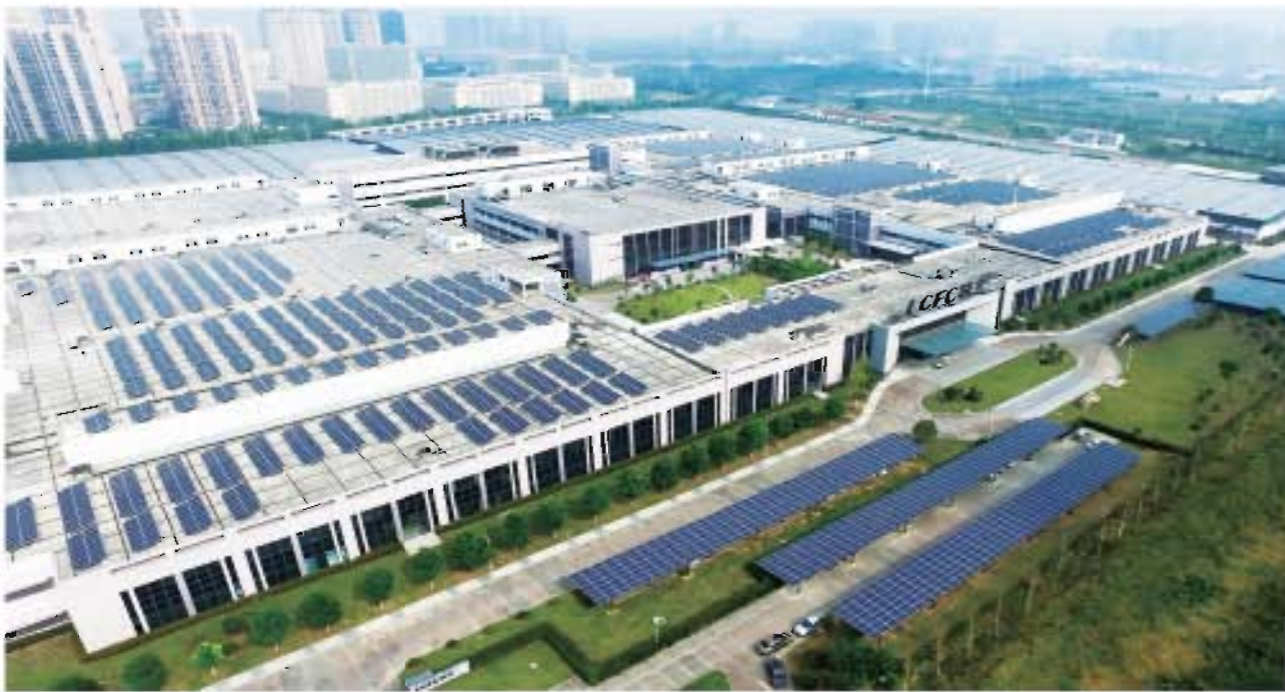
项目名称：联想全球最大“PC+”产业基地应用智慧光伏项目——联宝3.86MW光伏电站项目 并网时间：2016年
