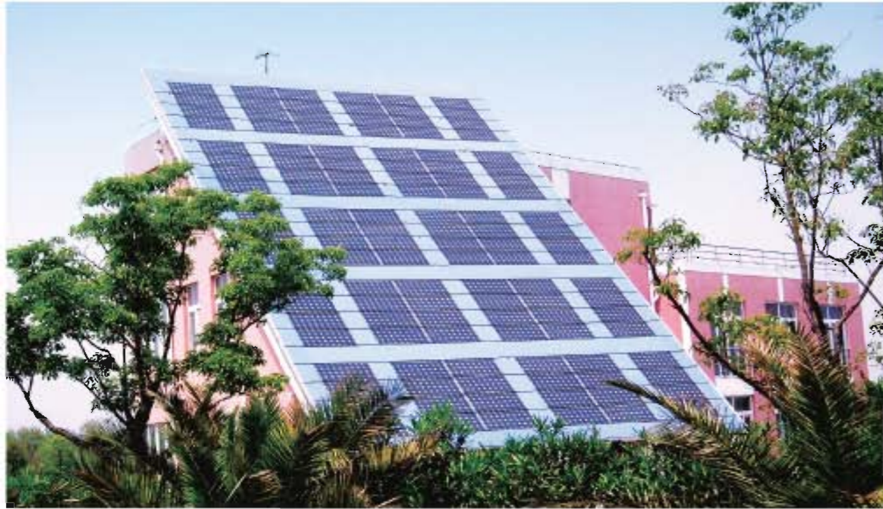
项目名称：中国第一个分布式光伏电站项目 上海奉贤 并网时间：2003年
