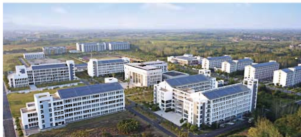
项目名称：安徽建筑大学城市建筑学院1.2MW光伏电站项目 并网时间：2017年
