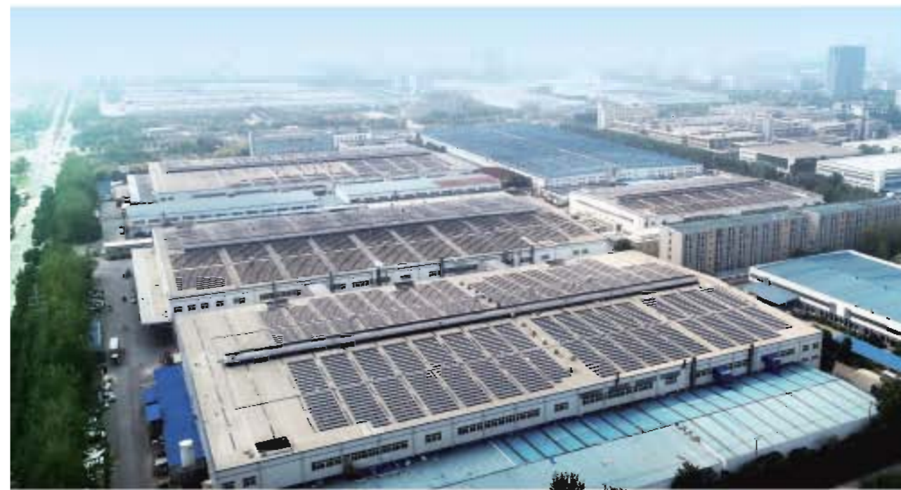
项目名称：美的冰箱工业园4.3MW光伏电站项目 并网时间：2014年
