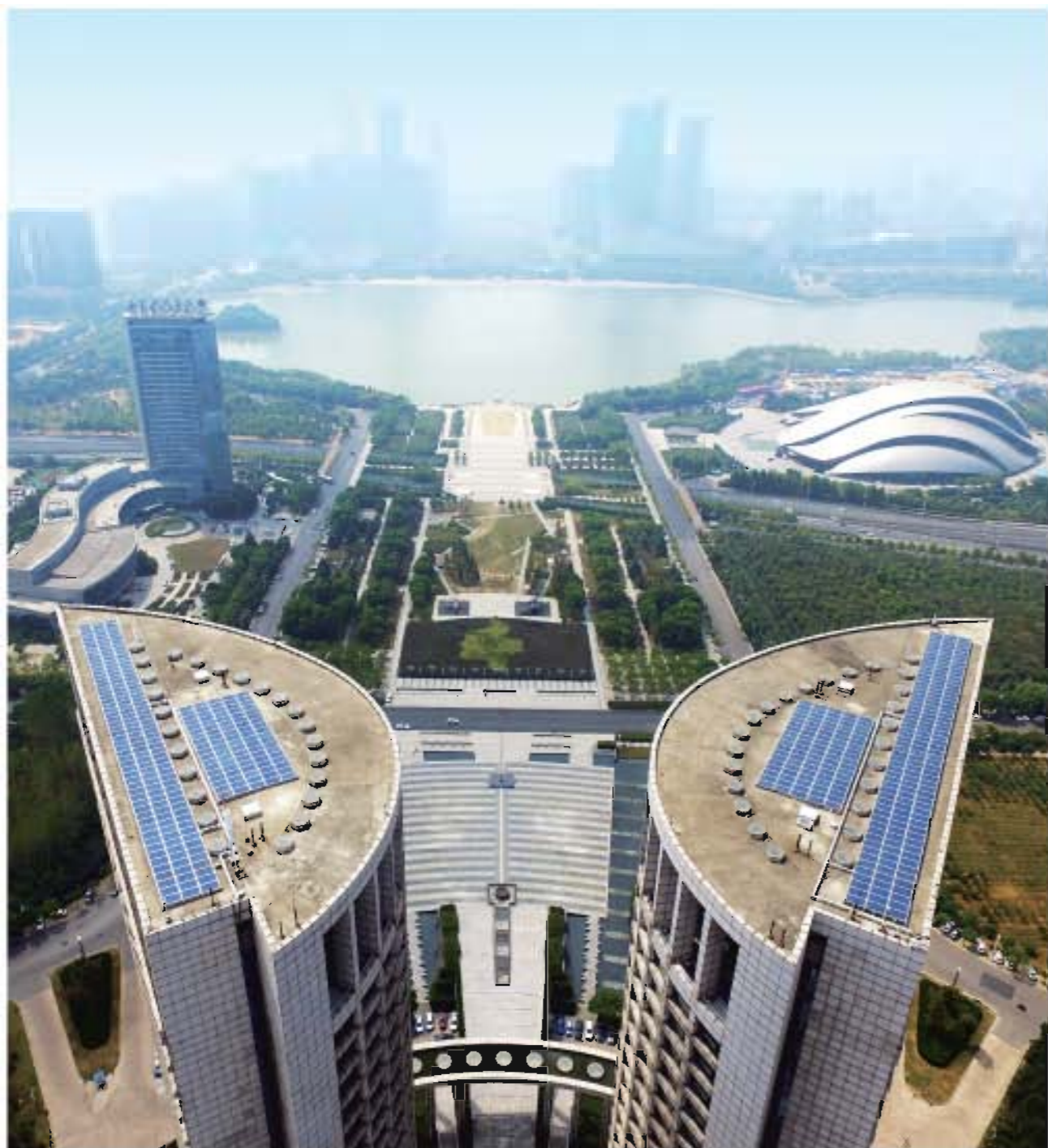
项目名称：公共建筑屋顶示范项目——合肥市政务中心0.127MW光伏电站项目 并网时间：2016年
