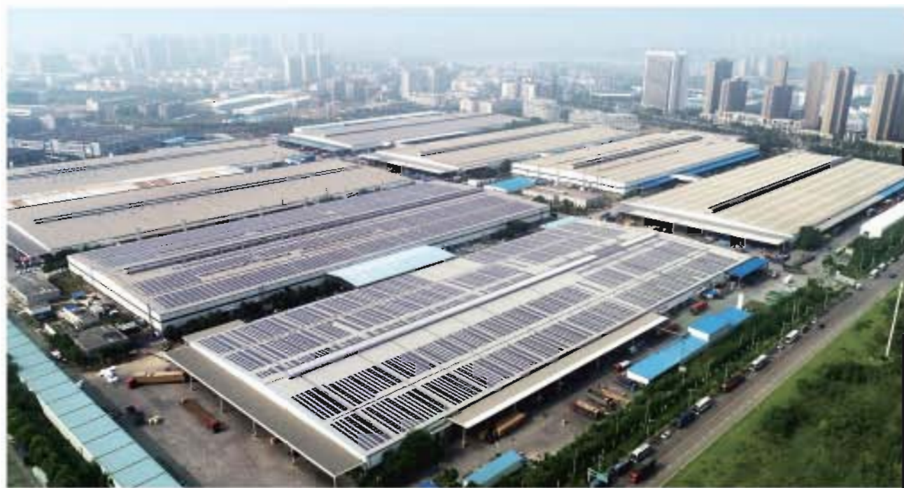
项目名称：美的洗衣机工业园4.83MW光伏电站项目 并网时间：2015年
