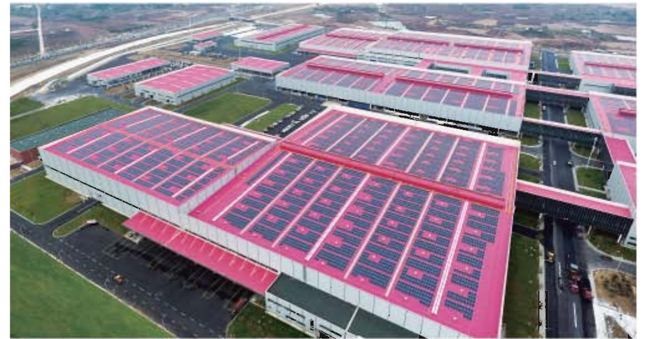
项目名称：江淮汽车高端及纯电动轻卡12MW光伏电站项目 并网时间：2017年
