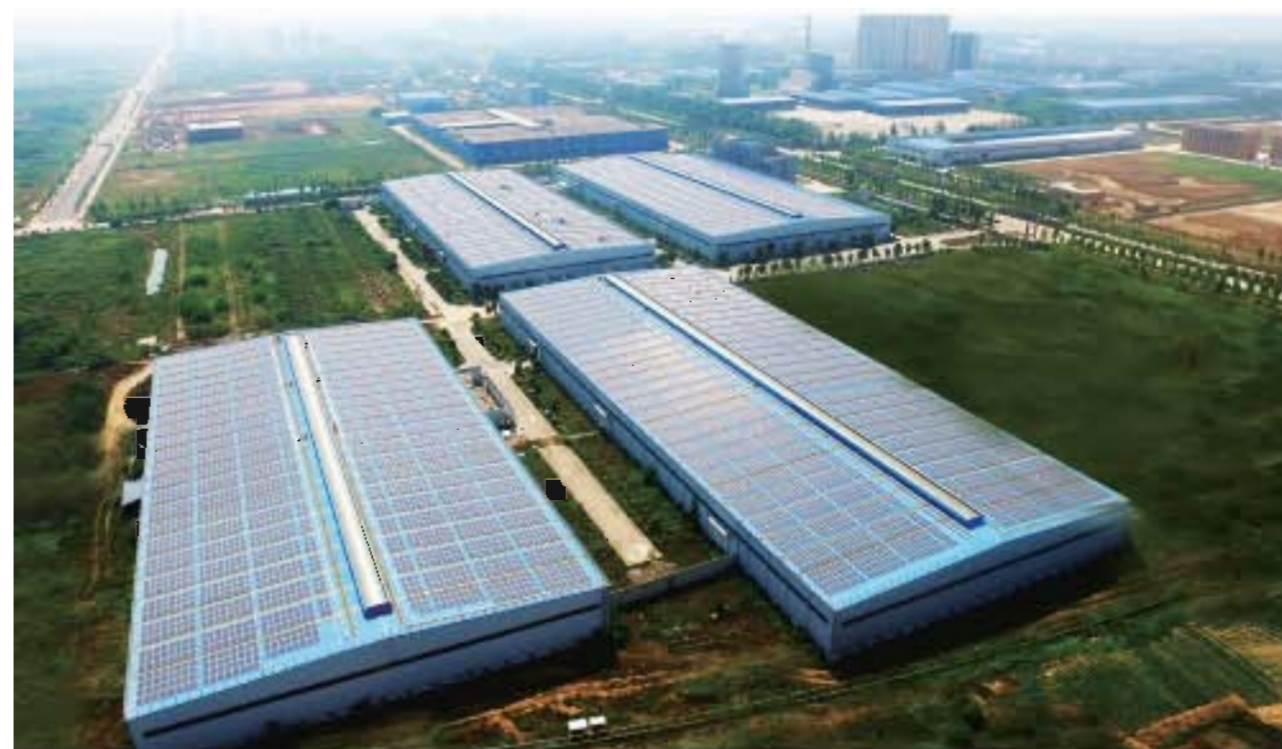
项目名称：安徽尊贵电器4MW光伏电站项目 并网时间：2018年
