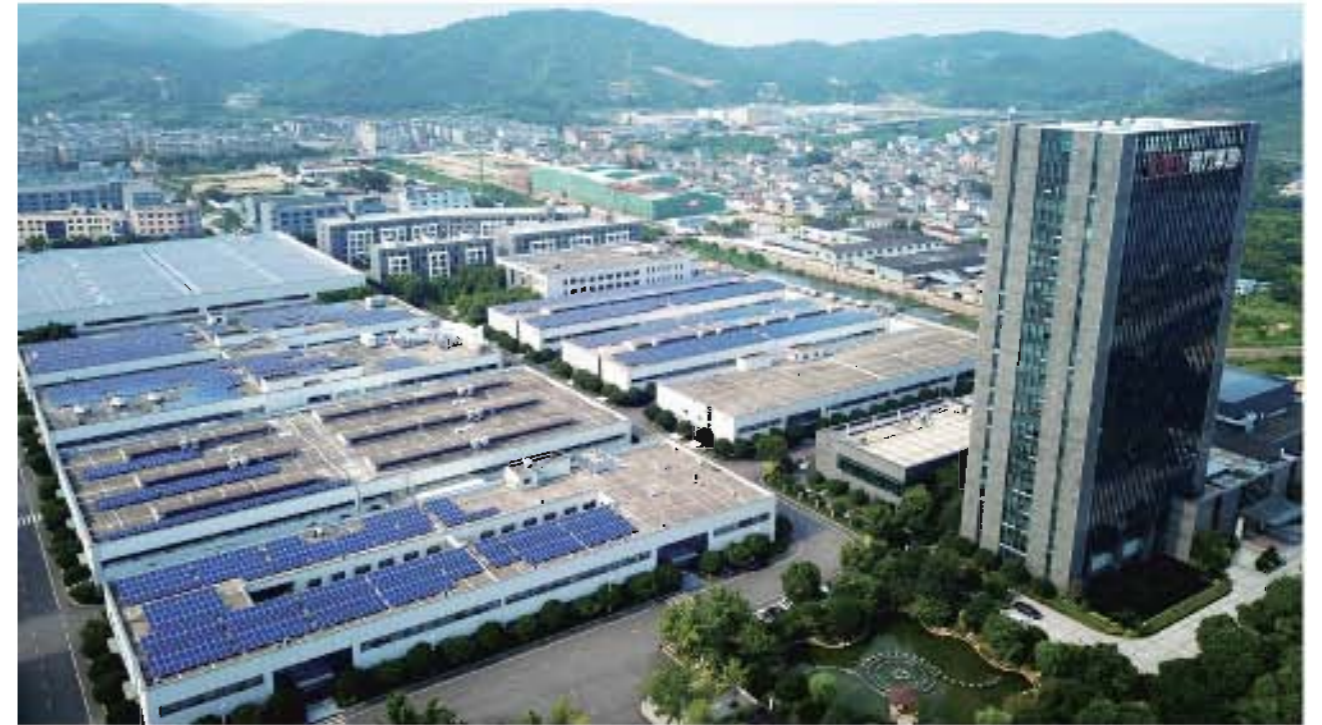
项目名称：全球办公文具巨头——得力集团9.2MW光伏电站项目 并网时间：2018年
