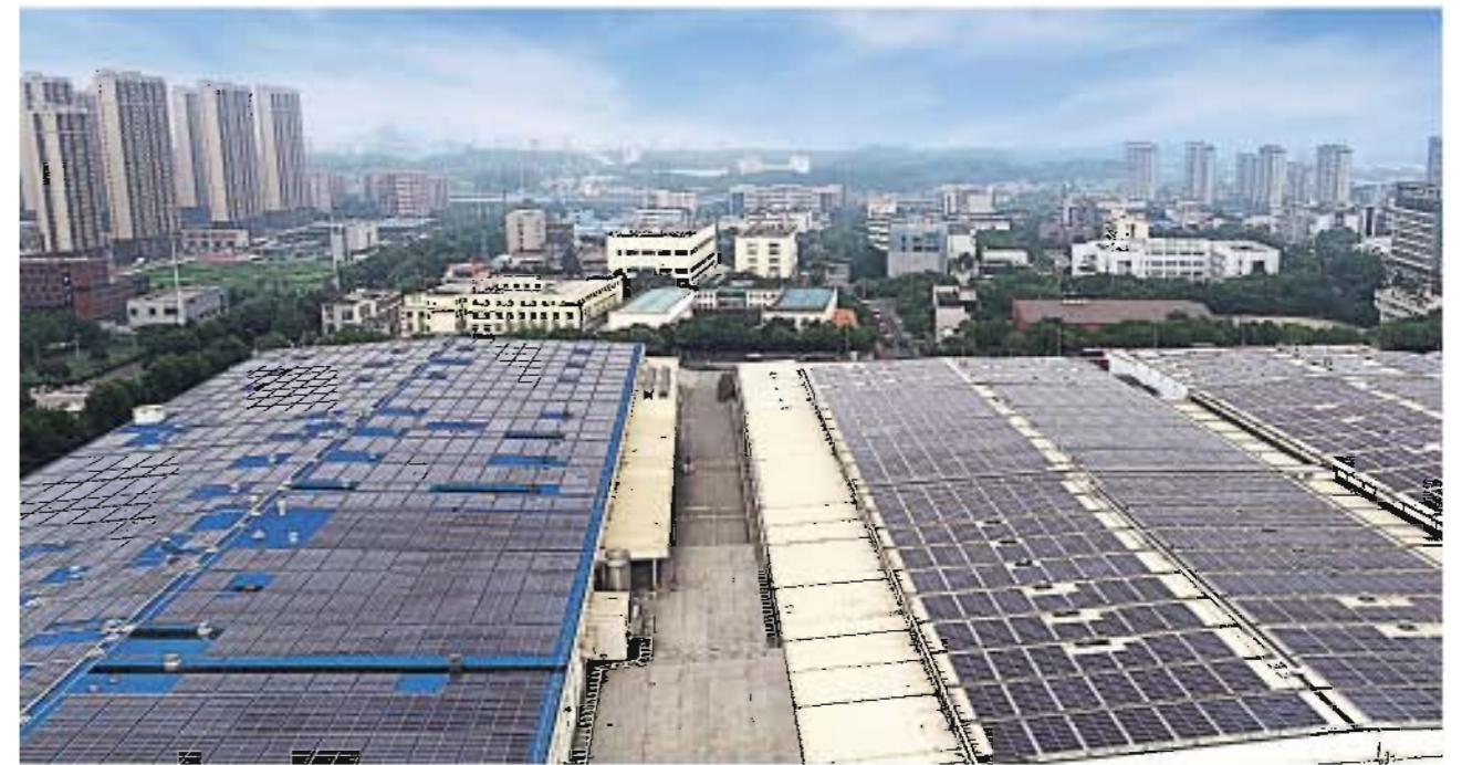
项目名称：南京可口可乐4MW光伏电站项目 并网时间：2019年
