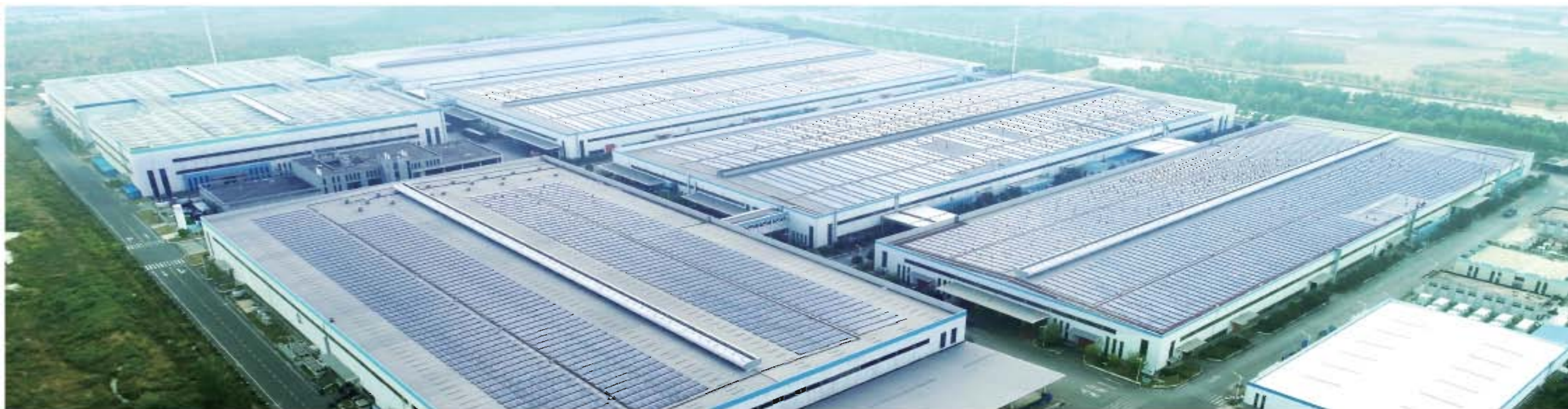
项目名称: 美的暖通设备9MW光伏电站项目 并网时间: 2014年
